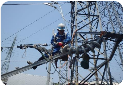
電気工事の分野では、送電～変電～配電～屋内外配線まで、全ての工事を行っています。
